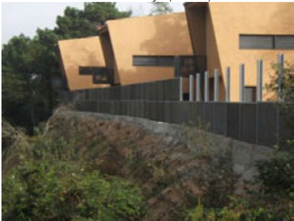
Urbanización carretera GI682. Lloret de Mar (Girona)
